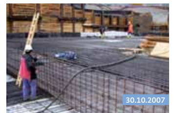
Für einen der Großkräne wurde ein Betonfundament gegossen.
